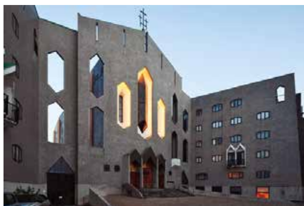
A sinistra: fig. 10. Michelangelo Buonarroti – Proposta per la facciata di San Lorenzo a Firenze (ricostruzione virtuale) Sopra, dall’alto: fig. 11. Duomo di Vigevano Fig. 12. Giò Ponti, chiesa di S. Francesco al Foppino, Milano, 1964
